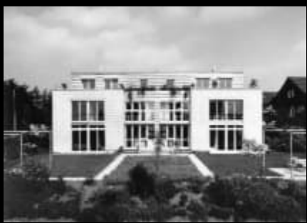
Haus Born, 1986-88 Kalksandstein, zweischalig
