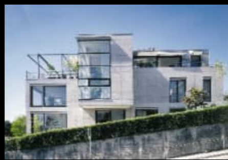
Haus Flühgasse, 1993-96 Beton, einschalig
