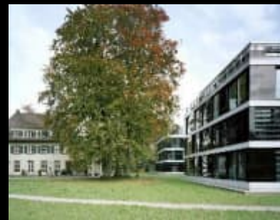
Fehlmann-Areal, 2016-20 PV, Beton
